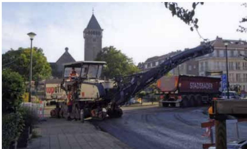
Travaux d'asphaltage du parvis Sainte Alix.
